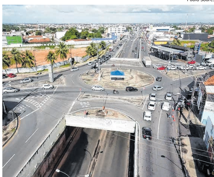
Com a continuação da obra, a rotatória da Cohab não vai mais existir
