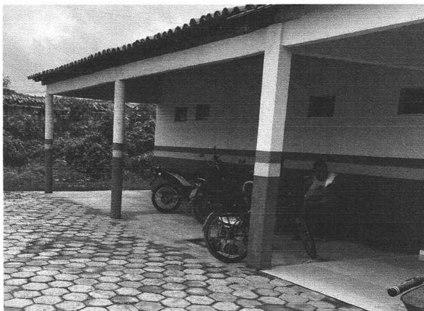
Área externa ampliada em prédio
