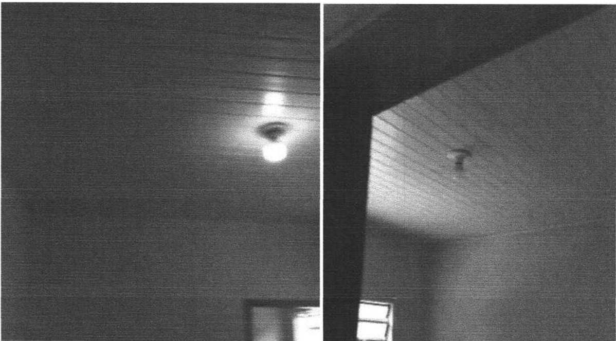
Restauração de forro.
