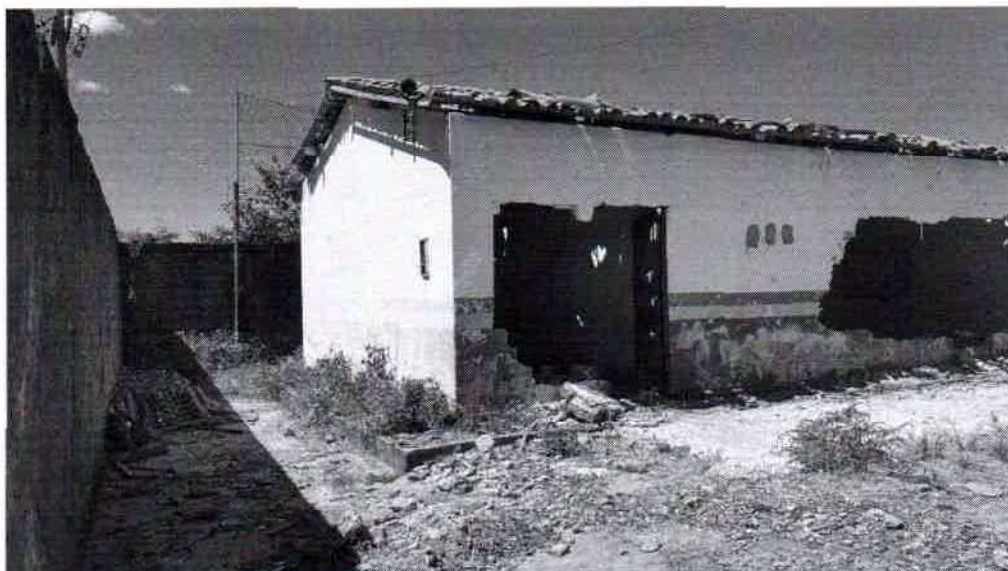
Vista da escola a ser reformada
