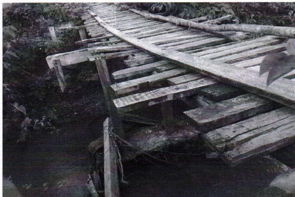
PONTE 3 – DEMOLIÇÃO E RECONSTRUÇÃO DE UMA PONTE DE MADEIRA, ZONA RURAL DO MUNICÍPIO DE DAVINÓPOLIS – MA – COMP: 20,00 m
