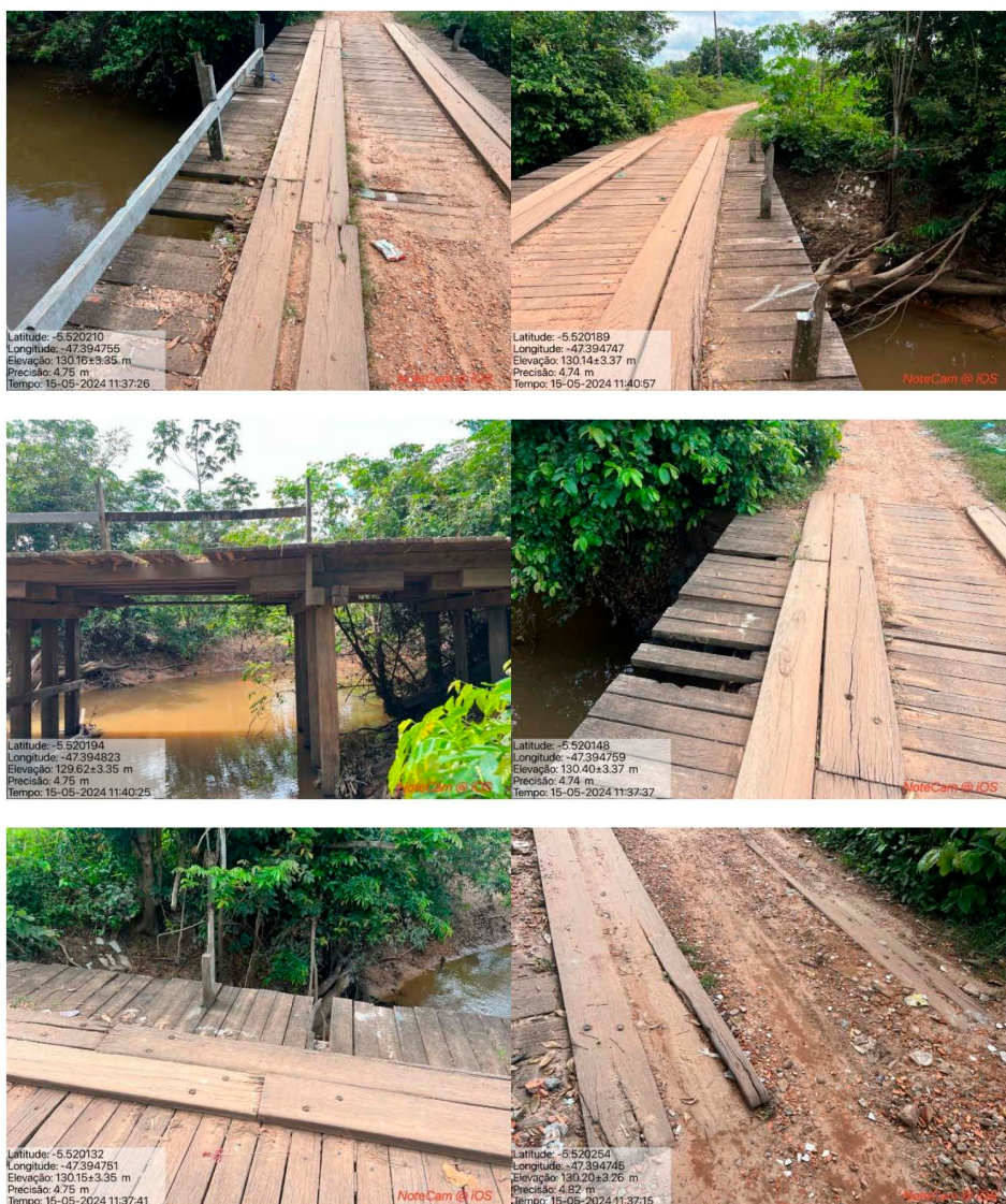
PONTE 1 – REFORMA DA PONTE SOBRE O RIO CACAU, SEDE DO MUNICÍPIO DE DAVINÓPOLIS – MA, COORDENADAS: 5°31'12.5"S 47°23'41.2"W – COMP: 17,00 m
